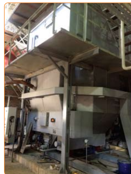
Рис. 4. Модернизация двух паровых котлов КЕ-10
